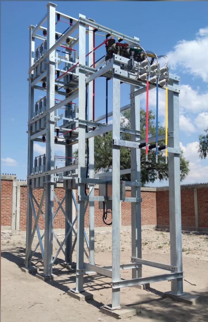
Los bancos automáticos y/o fijos de capacitores en media tensión, PLANCK TECHNOLOGIES están configurados en Nema 1 o 3R respectivamente. contenciones de **4.16, 13.8, 23 y 34.5 KV.**
